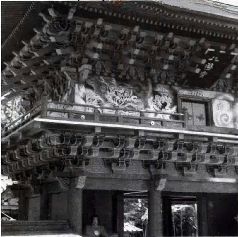
那須神社 楼門 [栃木県指定文化財]
